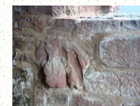
Bas-relief romain encastré dans la maçonnerie à l'intérieur du chœur de l'Altchurch, à droite sous la petite fenêtre Photographie : Jo Roll - année 2014
