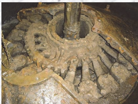
Démontage de la turbine pour révision Mécanisme de réglage du débit d'eau sous le couvercle
