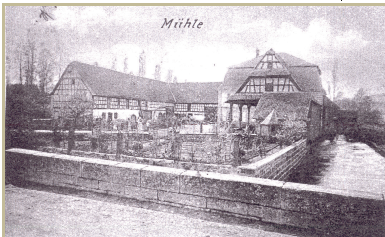
Carte postale – Vue du moulin vers 1900 avant la mise en place de la turbine. Toitures différentes sur l'eau, peut-être pour abriter les vannes et les roues...
