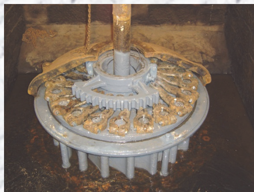
Remontage de la turbine – Mécanisme de réglage du débit d'eau par les 20 clapets
