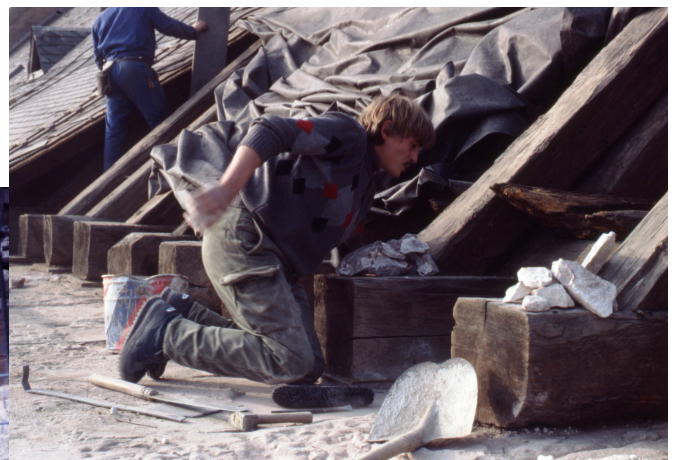
Remise en état et traitement des entrants reposant sur les murs extérieurs et soutenant le plafond
