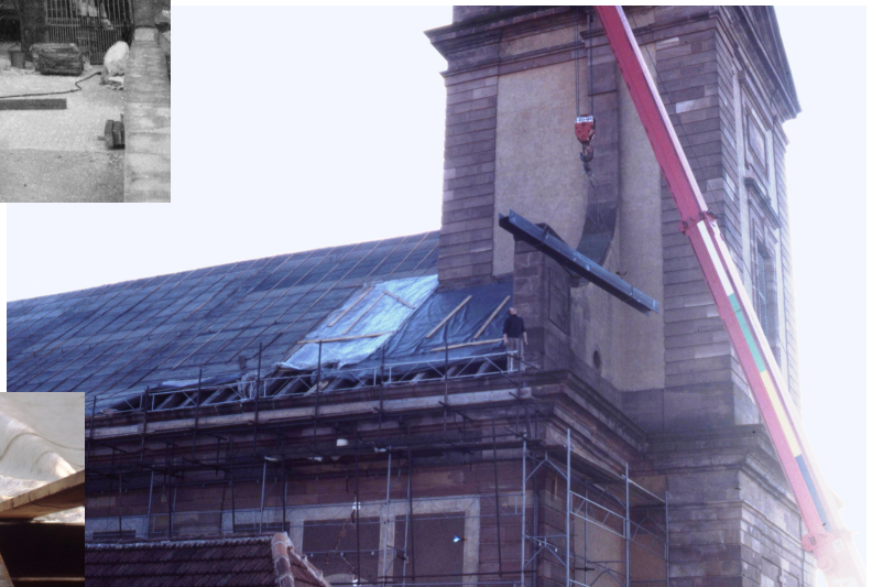
Chaînage mis en place pour le clocher
