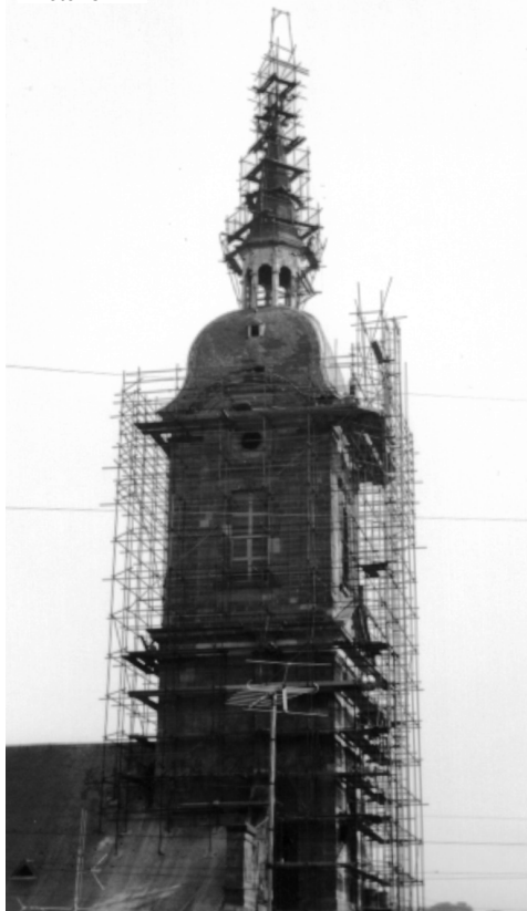
Travaux sur le clocher en 1966 / 1967
