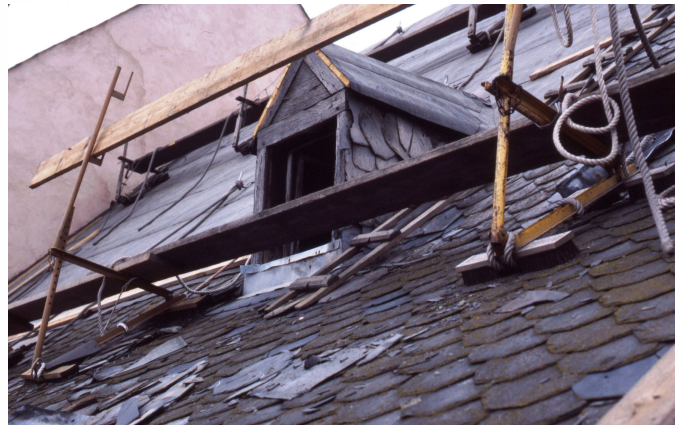
1984 - 1985 Travaux de la nef et du chœur : charpente, couverture et crépis
