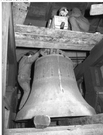
1983 : réfection du berceau des cloches, ici le bourdon 2750 Kg
