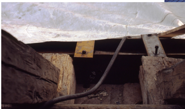
Chaînage mis en place pour le clocher
