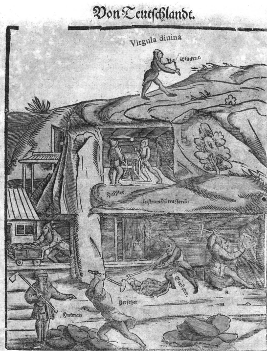
Exploitation du minerai en roche Selon AGRICOLA 1556
