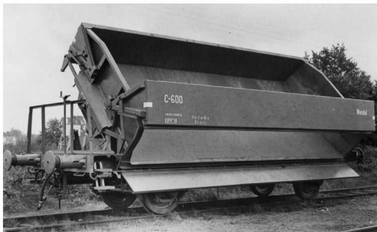
Wagon basculeur à déchargement bilatéral de 25 tonnes
