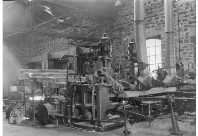
Machine d'entaillage et de perçage des traverses, Il y avait 9 hommes pour la faire fonctionner.
